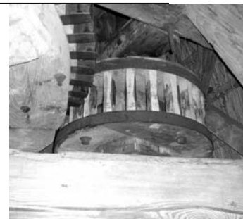
Het rondsel staat "in het werk", maar de molenaar kan het ook "uit het werk" zetten
